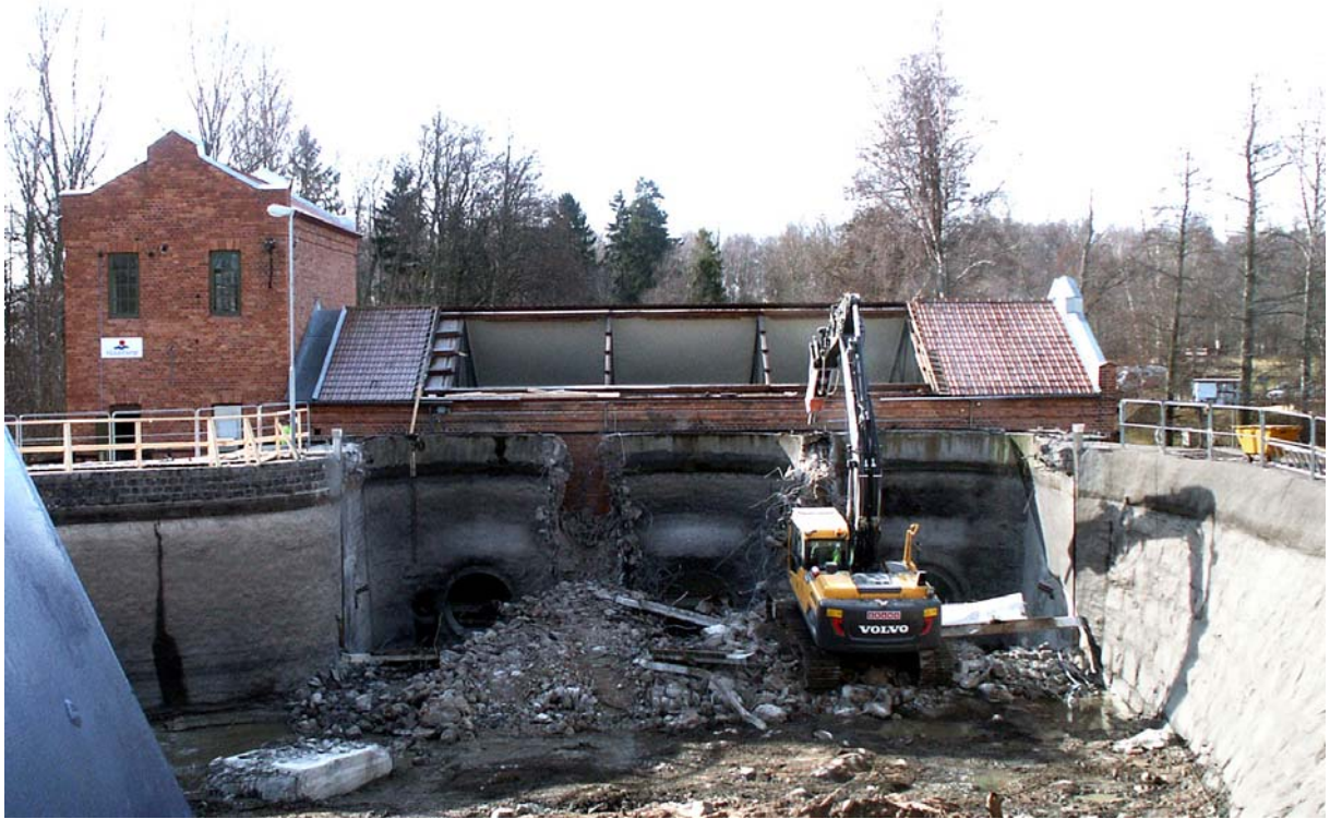
Ombyggnadsarbete pågår vid Västerkvarns kraftstation i Mölntorp.
