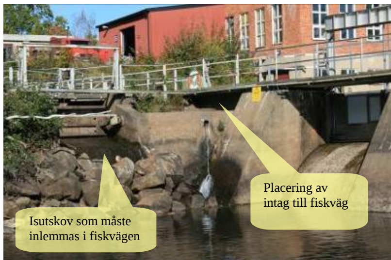
Figur 10. Dammen vid Sörstafors med isutskov samt förslag på placering av intag till fiskväg.
