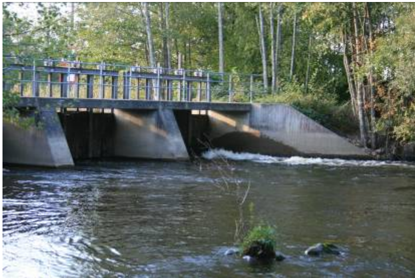
Figur 5. Kolbäcksån – Korsådammen bild från höger strand nedströms.
