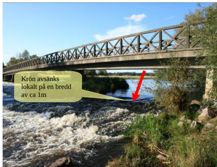
Figur 8. Damm vid Ladugårdsbron avsänks lokalt.
