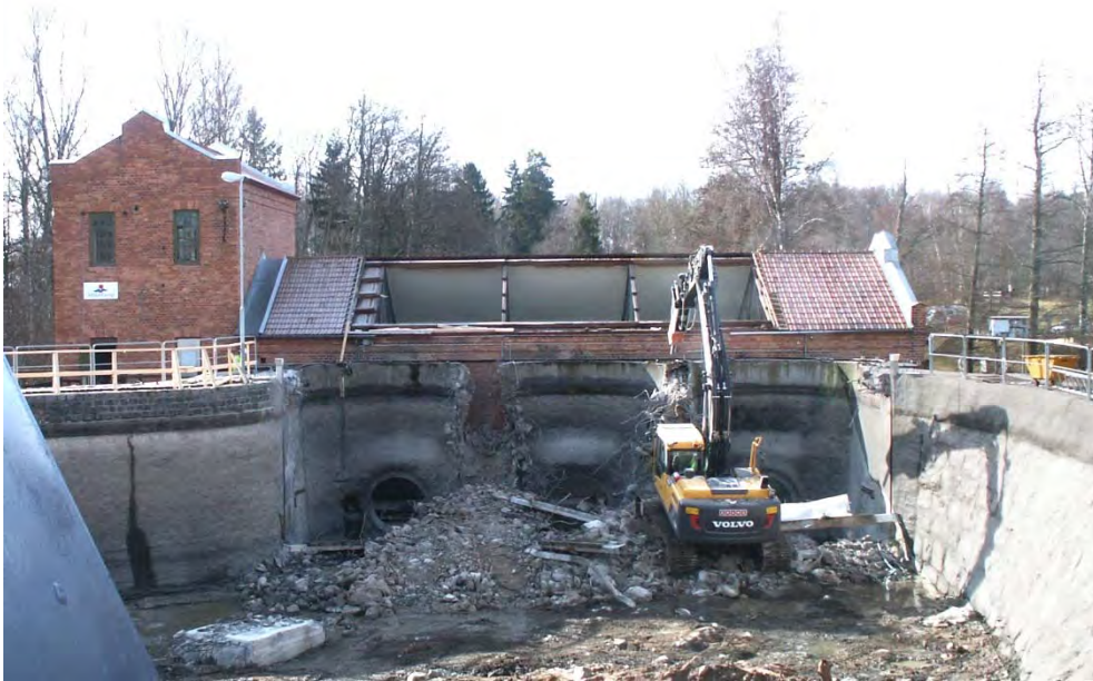
Västerkvarns kraftstation renoverades 2015. Foto: Kurt Larsson
